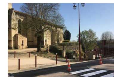
Marquage en résine gravillonnée
