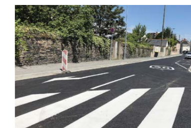
Marquage en résine thermoplastique
