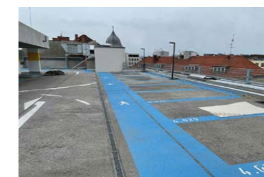
Sécurisation des piétons
