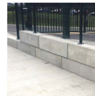
Mur de clôture
