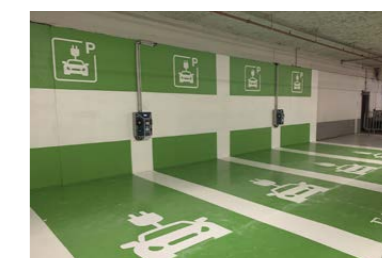
Résine intérieure Epoxy
