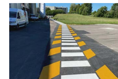
Sécurisation des piétons
