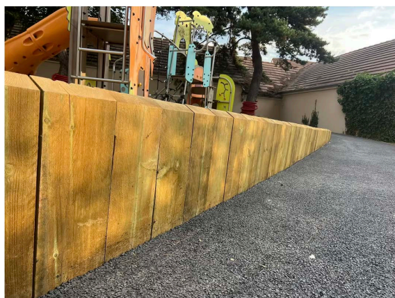
Sciage 5*20cm avec coupe en biais
